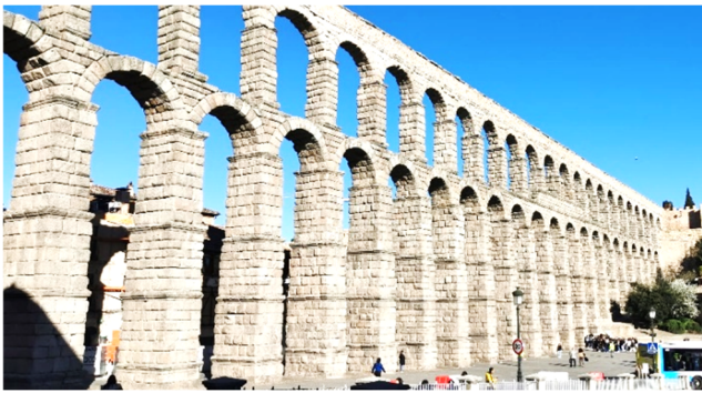
セゴビア水道橋 セゴビア県
